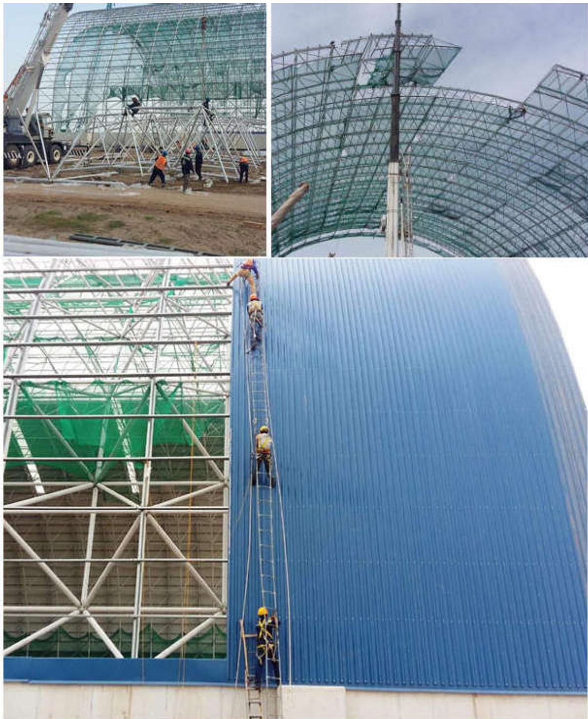
Công nhân đang thi công nhà than dự án nhiệt điện Thái Bình I
