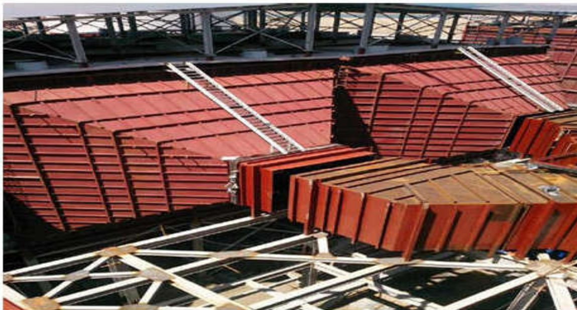
Lắp đặt hệ thống ống gió từ SCR ra lọc bụi tĩnh điện lò hơi 1# nhà máy nhiệt điện Duyên Hải I – Trà Vinh
