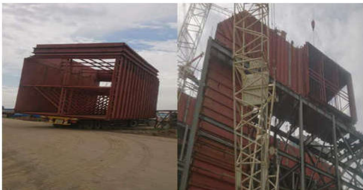
Vận chuyển và lắp đặt hệ thống đường gió nối giữa lọc bụi tĩnh điện với ống khói lò hơi 1# nhà máy Nhiệt điện Duyên Hải I – Trà Vinh
