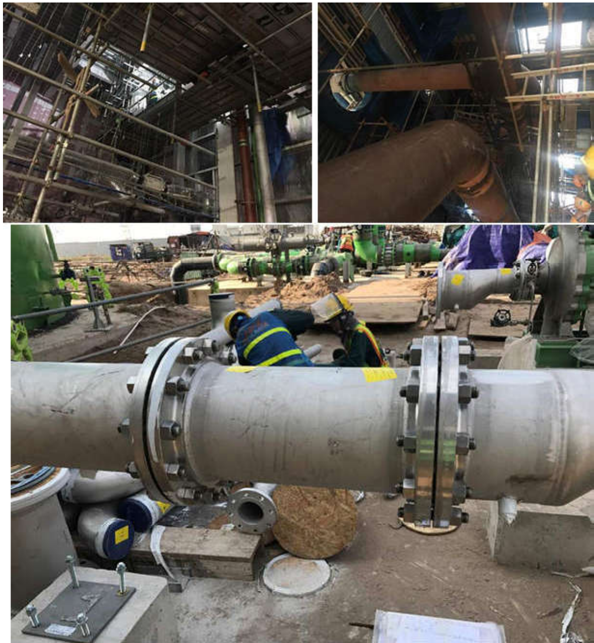
Công nhân đang thi công ống STG tại nhiệt điện Thái Bình 1 và Thái Bình 2
