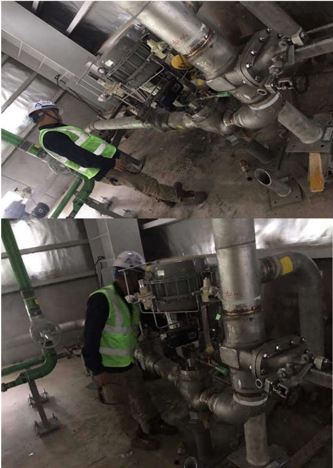
Cán bộ đi kiểm tra kỹ, mỹ thuật thi công
