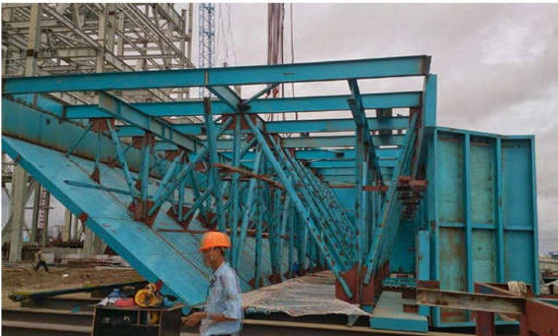
Gia công, hoàn thiện và chuẩn bị biện pháp cầu lắp đường gió nóng cấp 1 lò hơi 2# nhà máy Nhiệt điện Duyên Hải I – Trà Vinh
